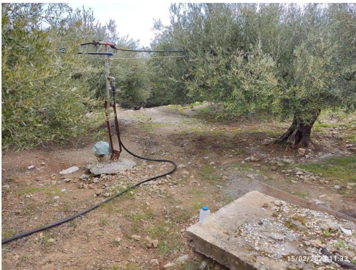
Εικόνα 4.2-22: Ιδιωτική Γεώτρηση θέση ΦΟΥΜΤΑΝΑ
