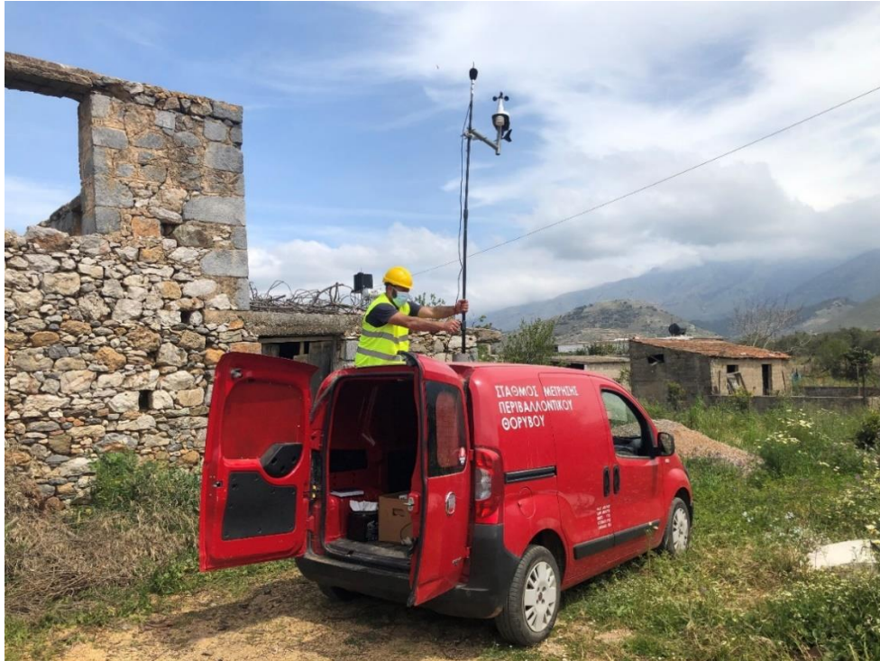
Εικόνα 4.4-4: Διαδικασίες εγκατάστασης εξοπλισμού μέτρησης περιβαλλοντικού θορύβου και μετεωρολογικού σταθμού
