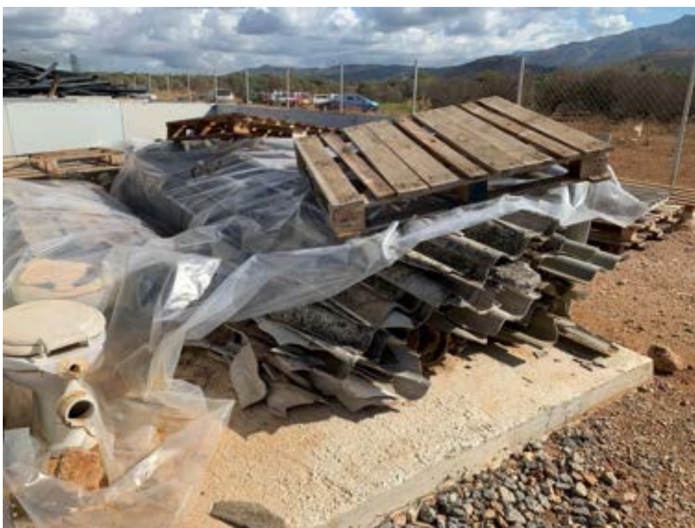
Εικόνα 26: Χώρος προσωρινής αποθήκευσης Αμιάντου
