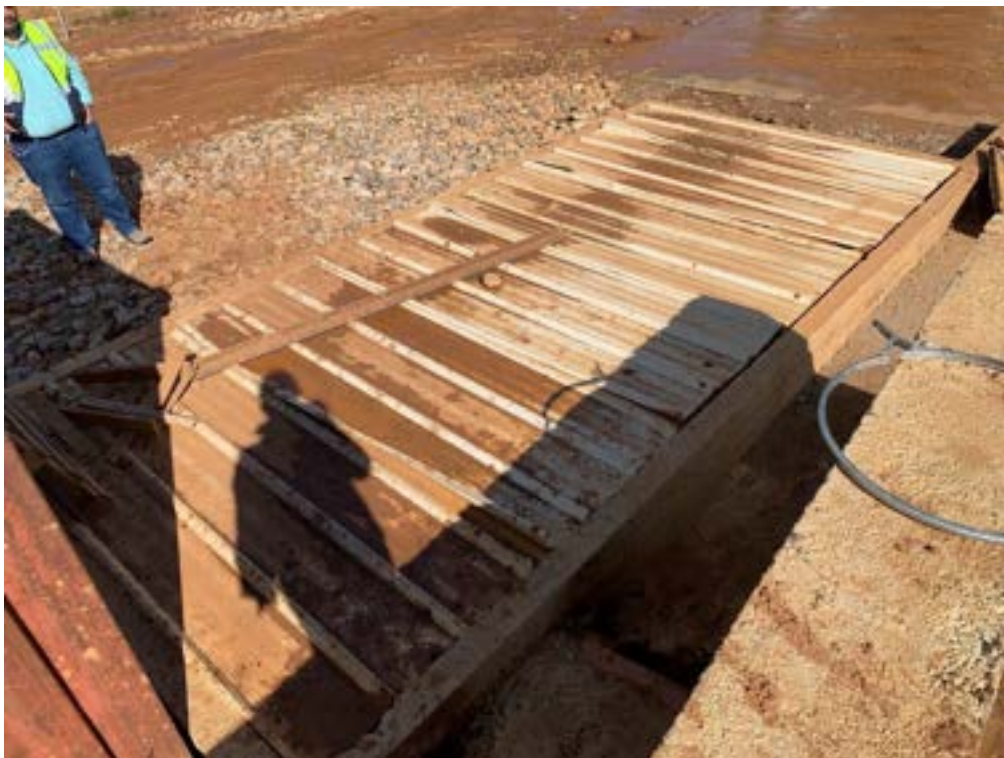
Εικόνα 4.6-8 Χώρος πλύσης φορτηγών οχημάτων – Δεξαμενή καθίζησης νερού/ελαιοδιαχωριστής
