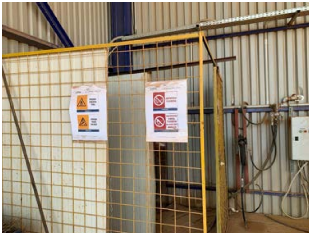
Εικόνα 11: Ειδικά διαμορφωμένος χώρος αποθήκευσης φιαλών αερίων υπό πίεση
