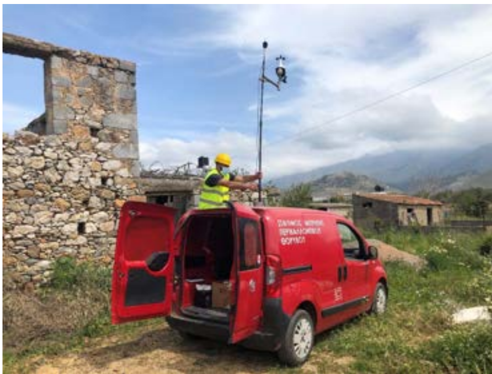
Εικόνα 5: Διαδικασίες εγκατάστασης εξοπλισμού περιβαλλοντικού θορύβου και μετεωρολογικού σταθμού
