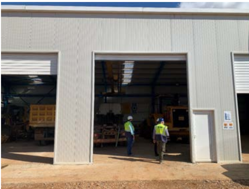
Εικόνα 3: Άποψη εξωτερικά του συνεργείου
