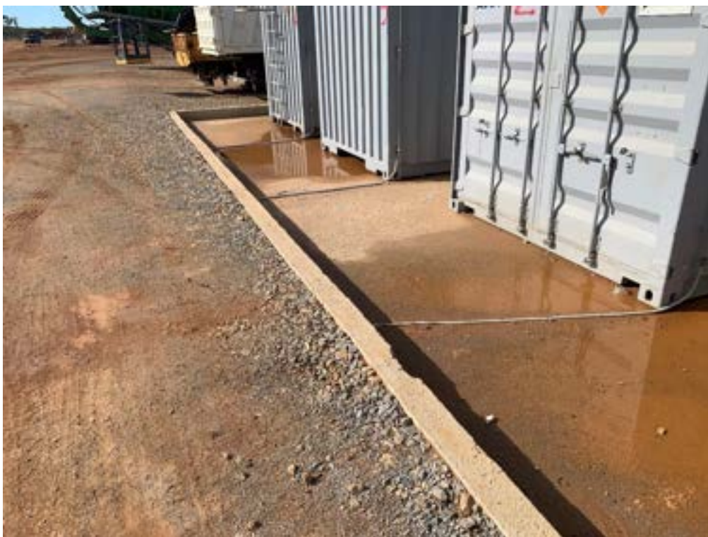
Εικόνα 5: Στεγανή βάση προστασίας απορροών δεξαμενών καυσίμων
