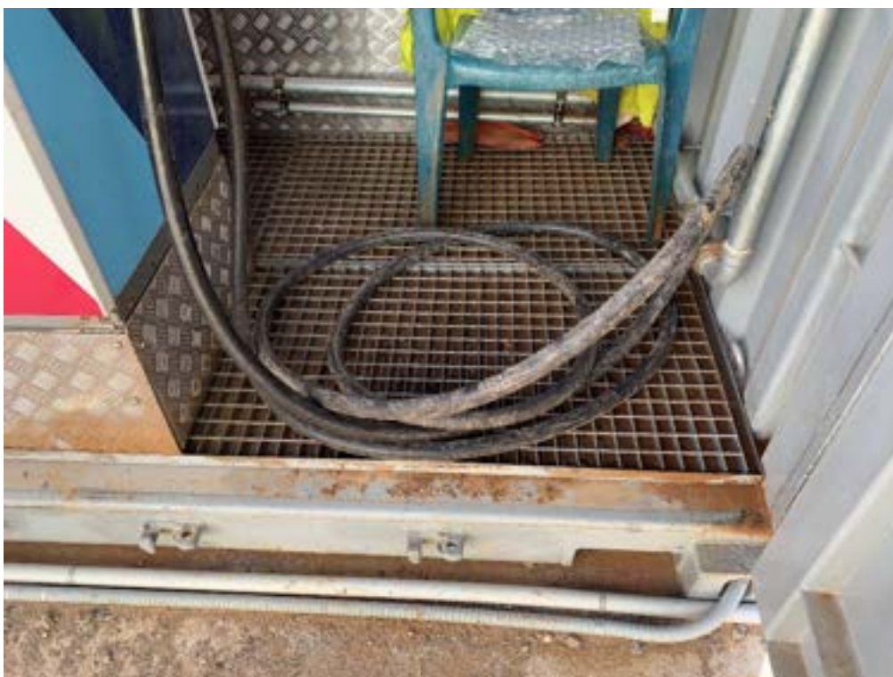
Εικόνα 6: Στεγανή βάση προστασίας απορροών δεξαμενών καυσίμων (εσωτερικά)
