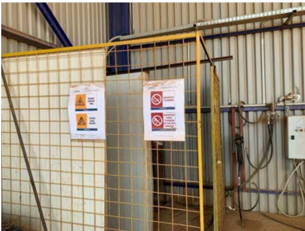
Εικόνα 4.6-5: Ειδικά διαμορφωμένος χώρος αποθήκευσης φιαλών αερίων υπό πίεση
