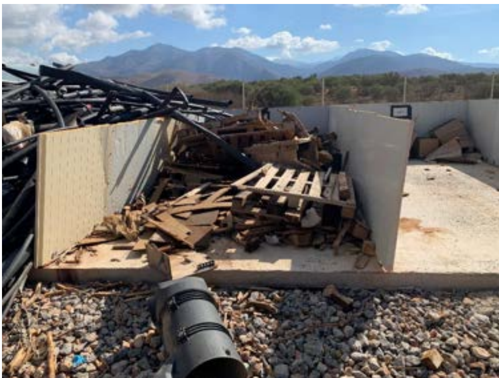
Εικόνα 4.6-20: Χώρος προσωρινής αποθήκευσης μη επικίνδυνων αποβλήτων – Ξύλο
