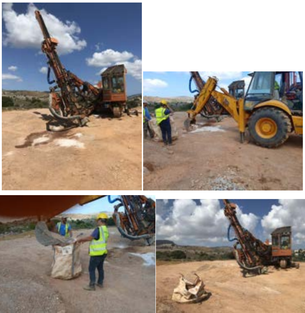
Εικόνα 4.6-16: Διαδικασία από αποκατάστασης διαρροής.
