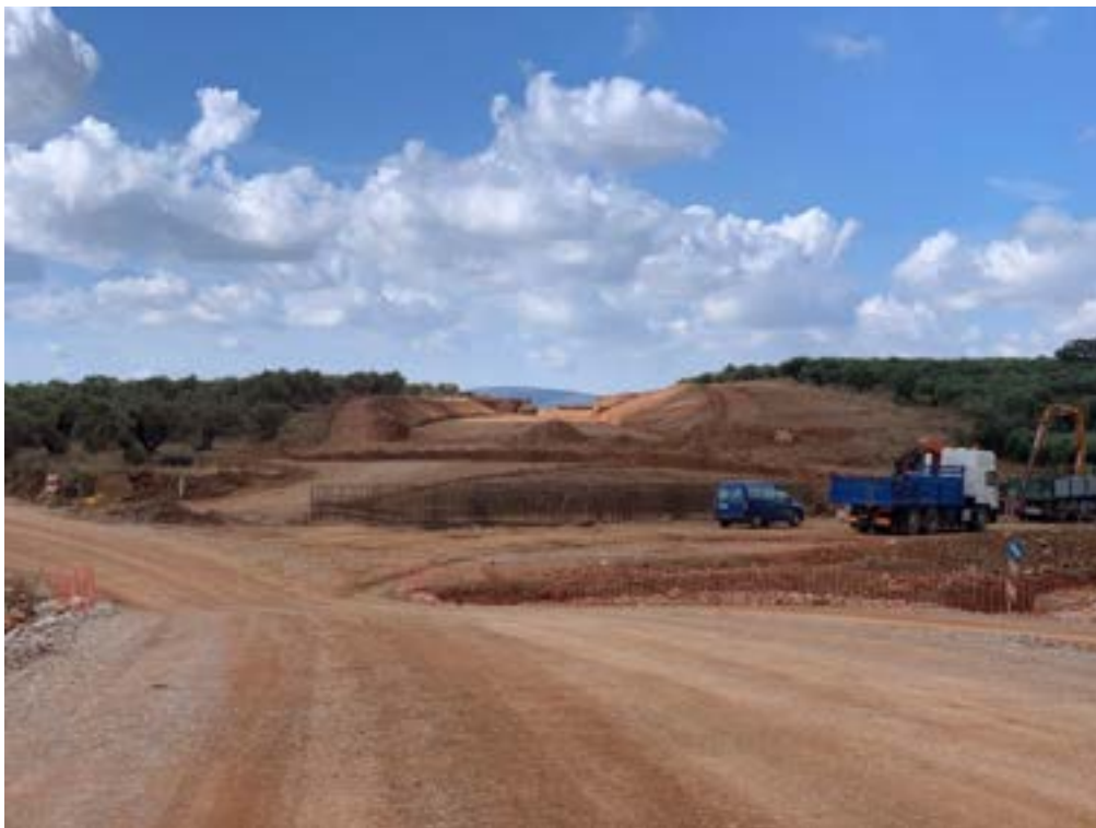
Εικόνα 39: Οδικό δίκτυο κατεύθυνσης προς αερολιμένα – υπό κατασκευή
