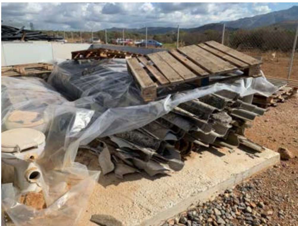
Εικόνα 4.6-4: Χώρος προσωρινής αποθήκευσης Αμιάντου
