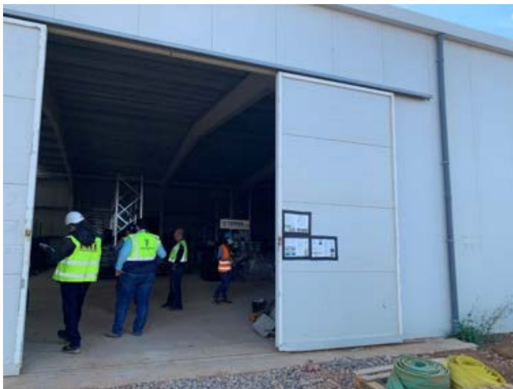
Εικόνα 4.6-12: Αποθήκη Υλικών εντός εργοταξιακού χώρου
