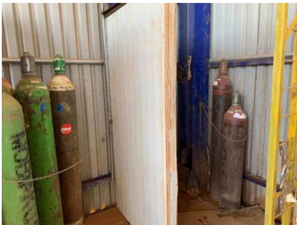
Εικόνα 12: Αποθήκευση φιαλών αέρα υπό πίεση
